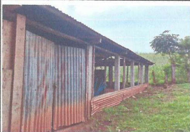
Foto1: MEJORAMIENTO MÓDULO TIPO PORTICO
