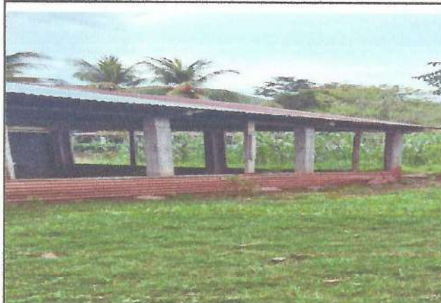
Foto 2: INSTALACIÓN DE LÁMINA TROQUELADA CALIBRE 26
